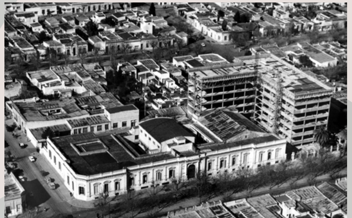
Vista aérea del nuevo edificio del ministerio de salud, década 1960
